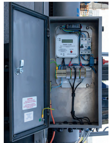
Рисунок 11. Шкаф управления на базе веб-сервера
